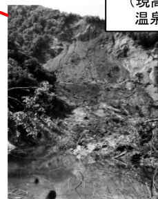
昭和28年7月 外ヶ谷の大崩壊で天然ダム形成
