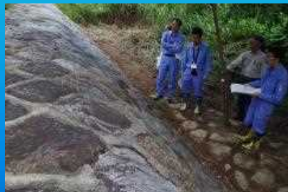
日川流域の砂防事業（勝沼砂防堰堤）
