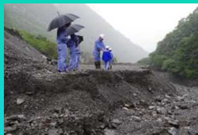
土砂流出状況
