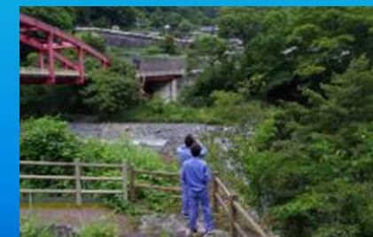
芦安砂防堰堤
