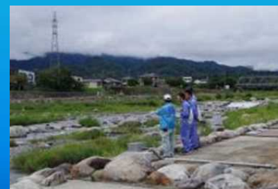
大武川流路工
