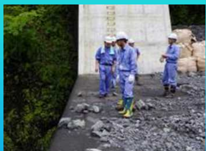
稲又砂防堰堤（天端）
