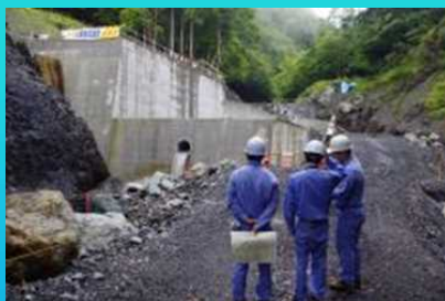
内河内第五砂防堰堤工事現場
