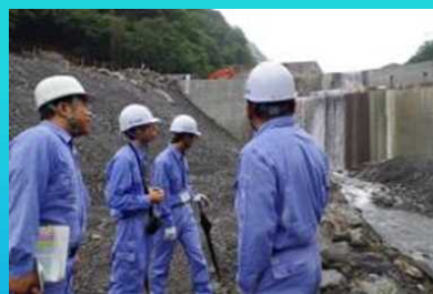
春木川第二砂防堰堤改築工事現場
