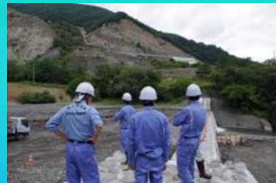
唐沢砂防堰堤改築現場
