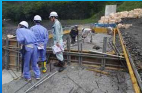
広河原砂防堰堤改築工事現場
